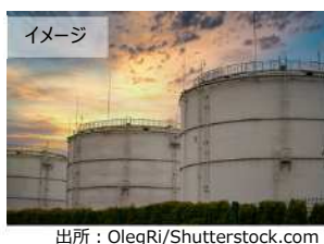
【水素・アンモニア受入タンク】
